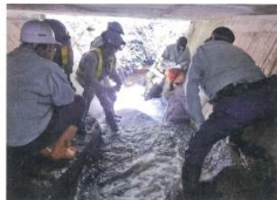
写真-3 専門家の方に点検のポイントの指導を受ける橋
