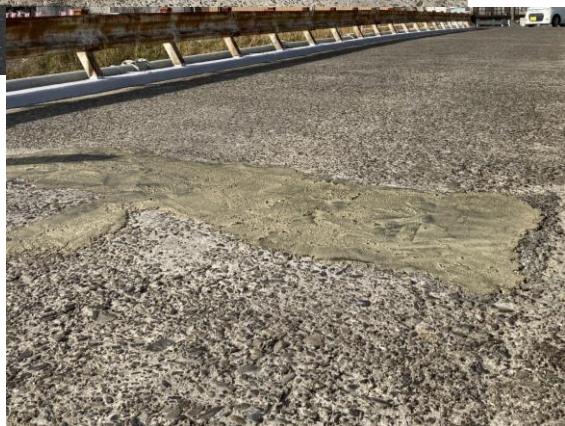
施工前 (断面修復済み)
