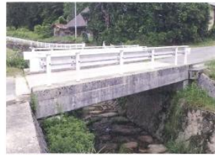
写真-2 代表的な橋(橋梁9.0m、RC床版橋)
