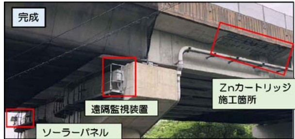
(2) 遠隔監視装置を用いた測定
