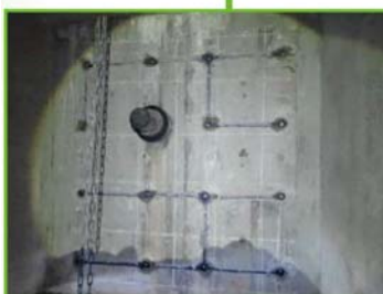
端部横桁にインサートタイプを設置します。桁内側から設置工事を行い遊間目地部鋼材の腐食を抑制します。
