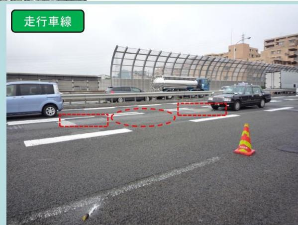
舗装のコンクリート補修直近のアスファルト部の損傷進行が見られる
