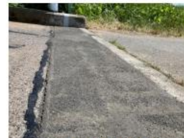
ニンジャシール施工完了
