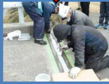
2次止水（ニンジャシールNEWソフト）の施工
