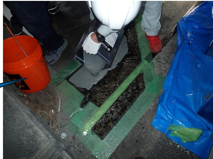
ニンジャシール 流し込み
