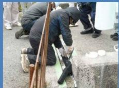
3次止水（メジエイド）の施工
