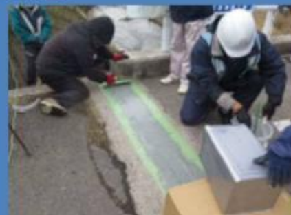
1次止水（ニンジャシール）の施工
